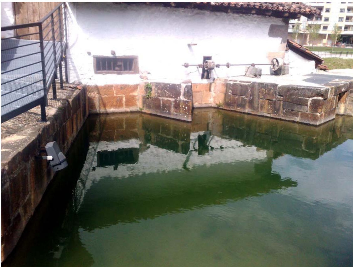
Deposito del Molino de Igarza (Yarza)
