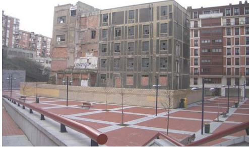
El edificio de molturación antes de su restauración.
