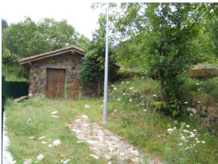
Estado actual del molino en 2007
